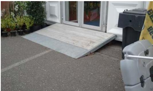
Der zu überwindende Höhenunterschied zwischen der Platzfläche und dem Eingang lag zwischen 30 und 45 cm, die Rampenlängen betragen zwischen 1,4 und 1,5 m.
