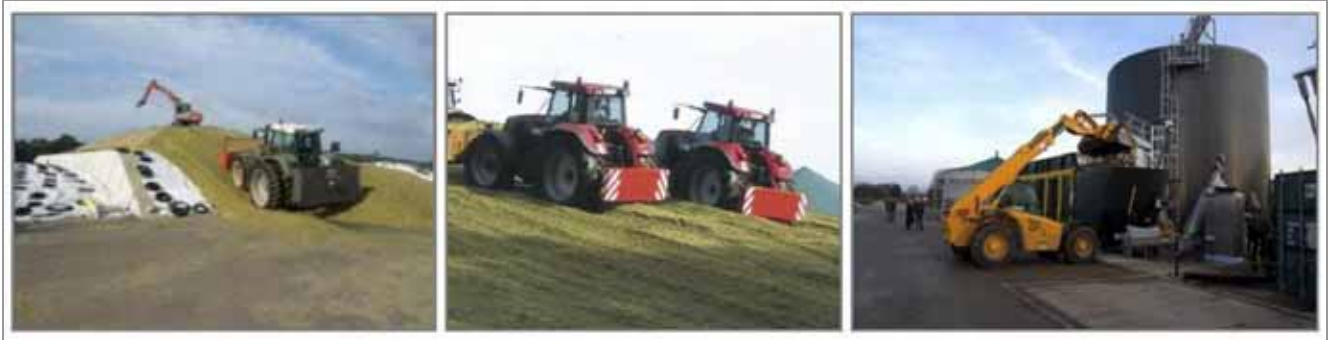
Abbildung 1-2: Transport und Einbau auf der Biogasanlage [Quelle: div. Fahrzeughersteller]
