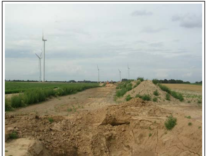
Bild 3: Trasse für die Nord-Süd-Wassertransportleitung zwischen Wanlo und Holz
