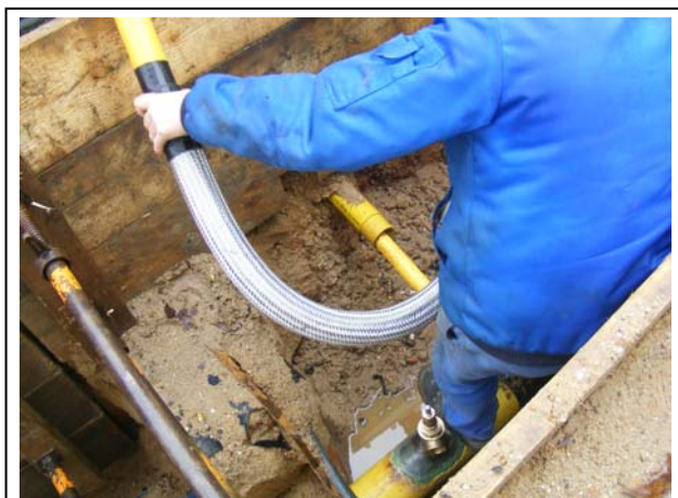
Bild 4: Einbau einer flexiblen Gasanschlussleitung im Querungsbereich des Rheindahlener Sprungs an der Talstraße
