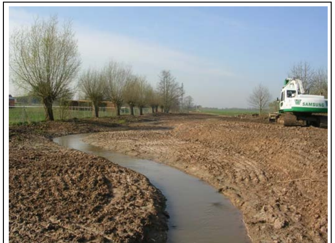
Bild 4: Umbau der Niers bei Wanlo
